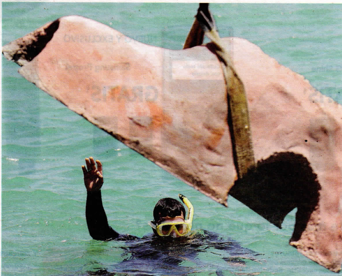
UN BUZO ayudó a colocar ayer uno de los nódulos de arrecife artificial que ahora reposa en el fondo de las aguas de la Laguna del Condado.
